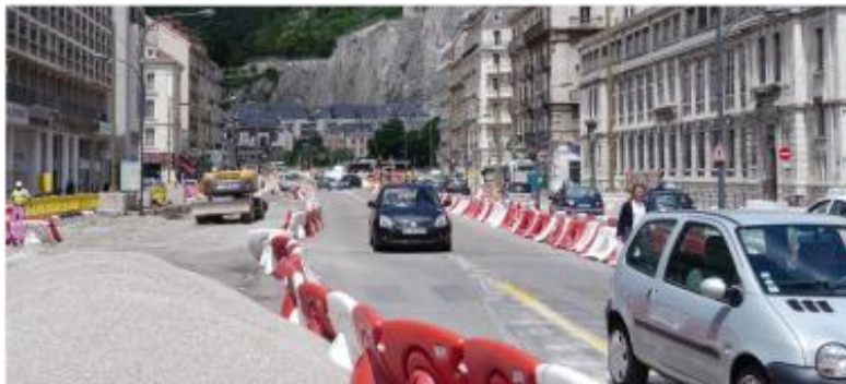
Chantier du tramway de Grenoble (38).
